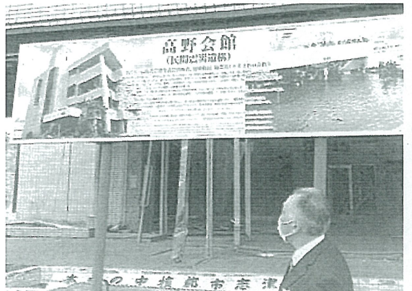
高野会館は震災遺構では珍しい民間施設だ（宮城県南三陸町）
