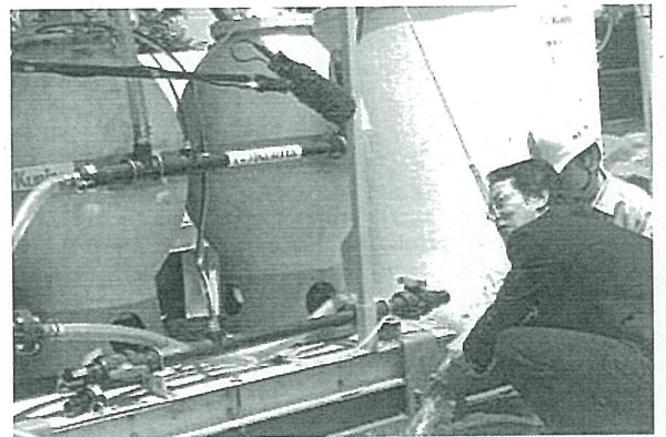
海水を淡水化するシステムの導入でホテルの水利用が大きく改善した(2011年6月)
